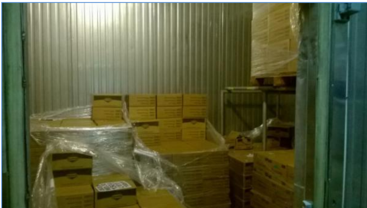
Cámara de Congelados: trabaja entre - 13° y - 16° de temperatura
