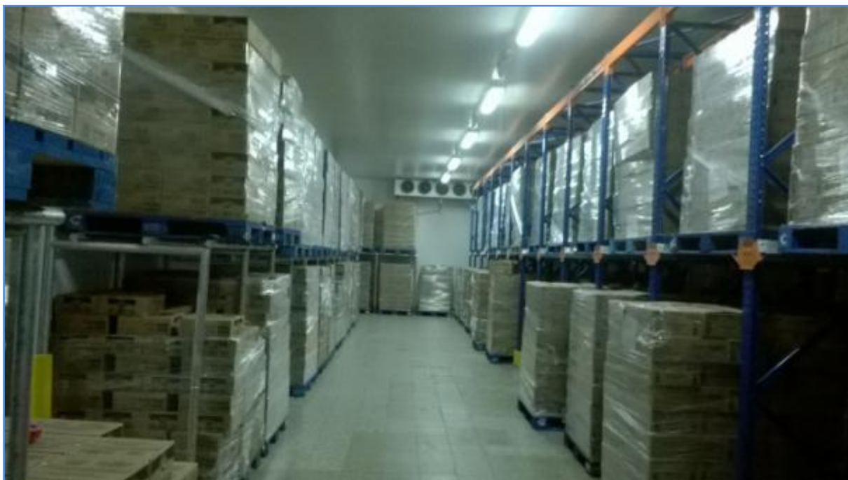
Cámara 2: trabaja entre 0° y 4° de temperatura
