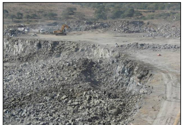
Figura 32 - Después de Voladura
