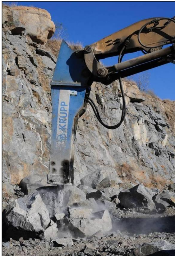
Figura 34 - Ruptura de Roca con Martillo Hidráulico
