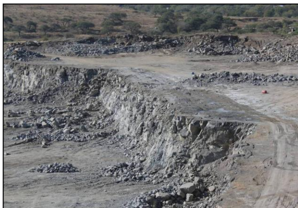
Figura 33 - Antes de Voladura
