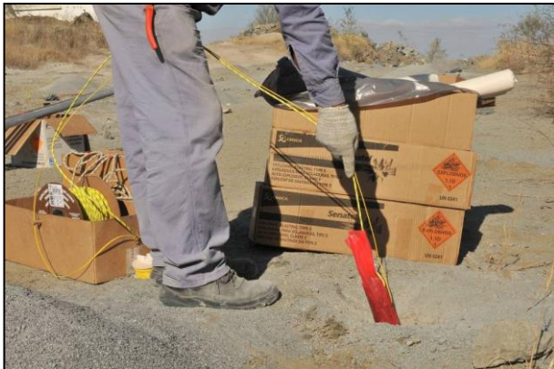
Figura 29 - Introducción de Explosivo en Barreno
