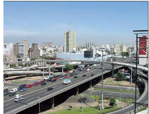
Figura 18 - Autopista Rosario - Santa Fe
