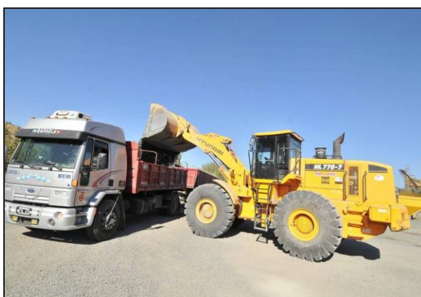
Figura 42 - Carga de Camión con pala mecánica
