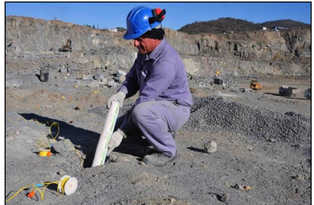
Figura 28 - Colocación de Sismógrafos
