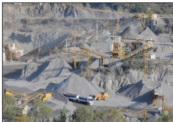
Figura 38 - Vista aérea de Planta de Trituración
