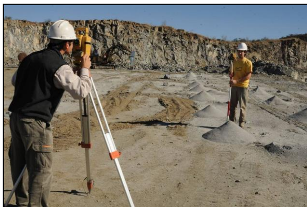
Figura 27 - Nivelación para la perforación
