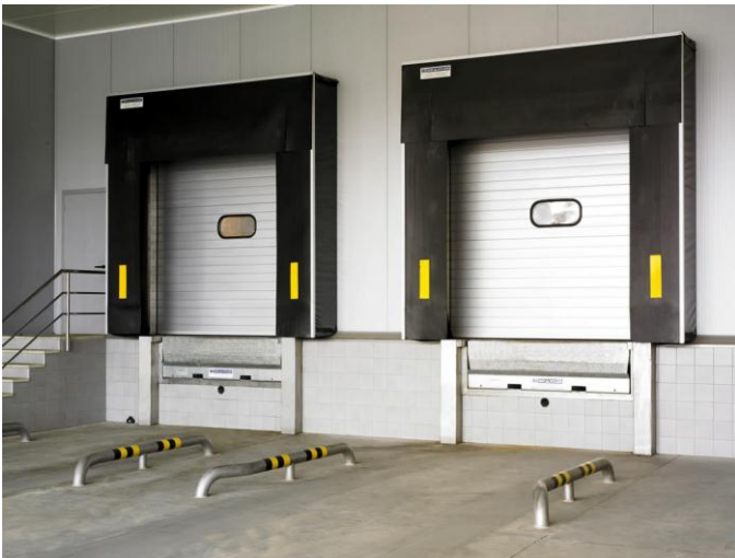
Imagen ilustrativa 10: Puerto de carga y descarga.
