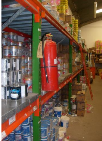
FIGURA 61-Matafuegos chicos distribuidos en todo el depósito
