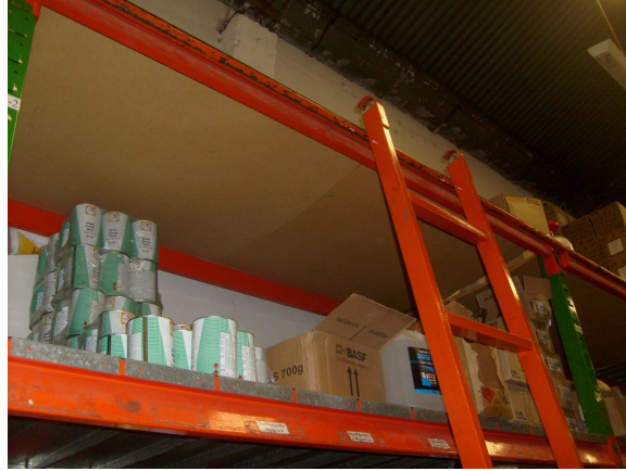
FIGURA 39-Estanterías y escaleras con travesaño superior y enganche
