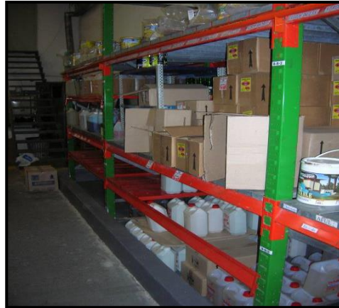
FIGURA 59-Piletones contenedores anti derrames
