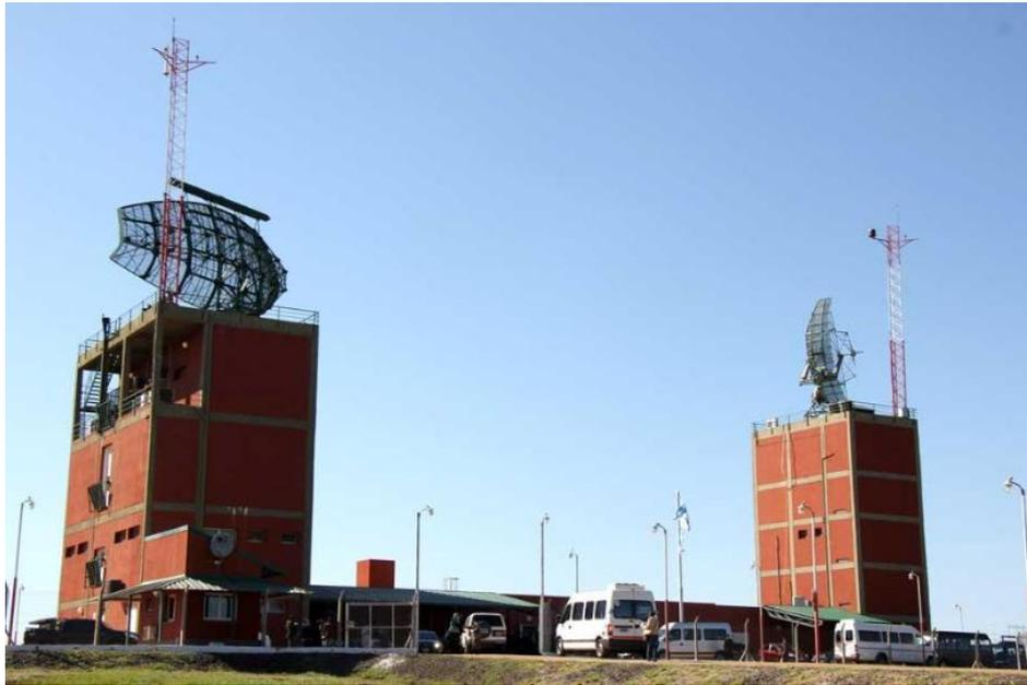
FIGURA 1.3: Radar Bendix AN/FPS-113 en el Centro de Vigilancia Aeroespacial Posadas
