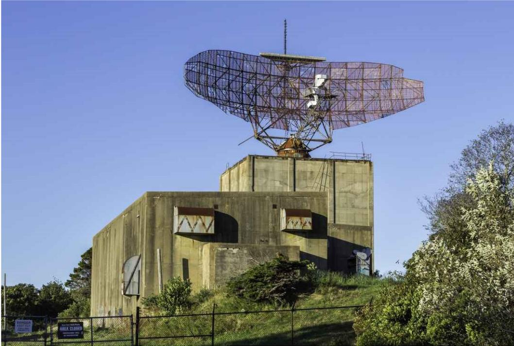
FIGURA 2.1: Radar AN/FPS-35 en Long Island, New York, EEUU. Se observa la gran antena correspondiente al Radar Primario, y una pequeña antena horizontal en la parte superior, correspondiente al Radar Secundario.
