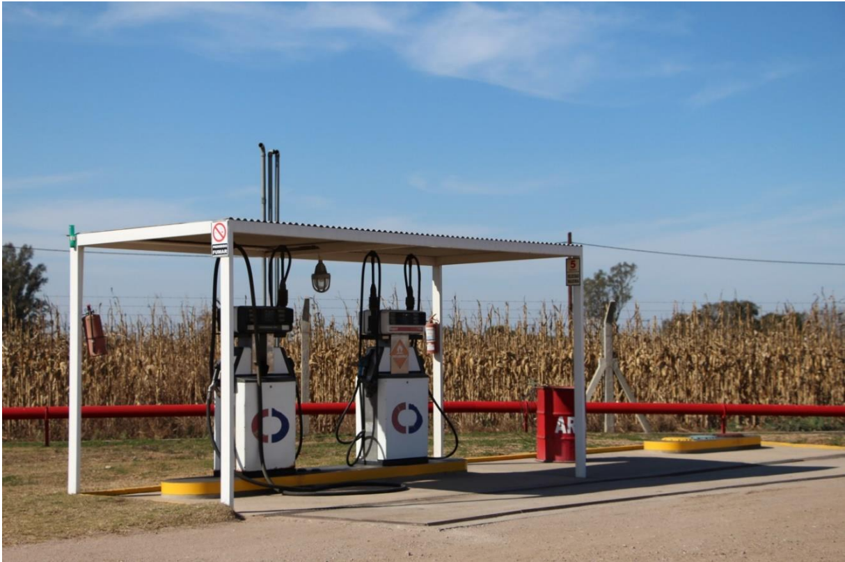
Figura 9 - Foto: zona de tanques subterráneos.
