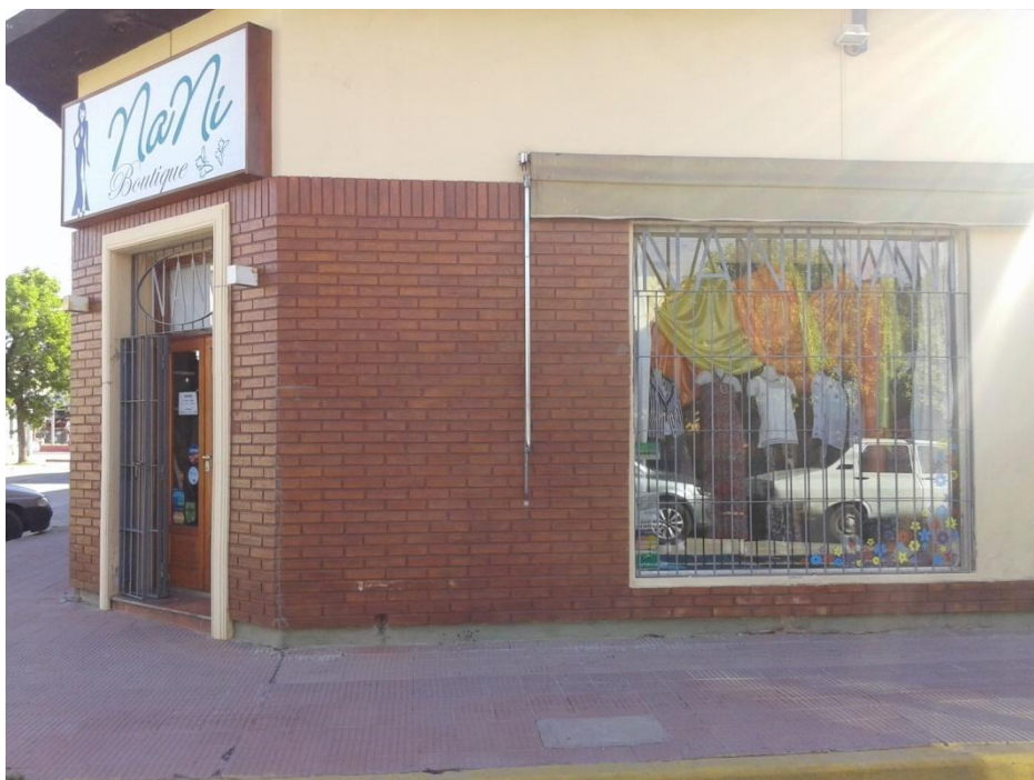
FOTO N°2: Frente y costado del comercio
