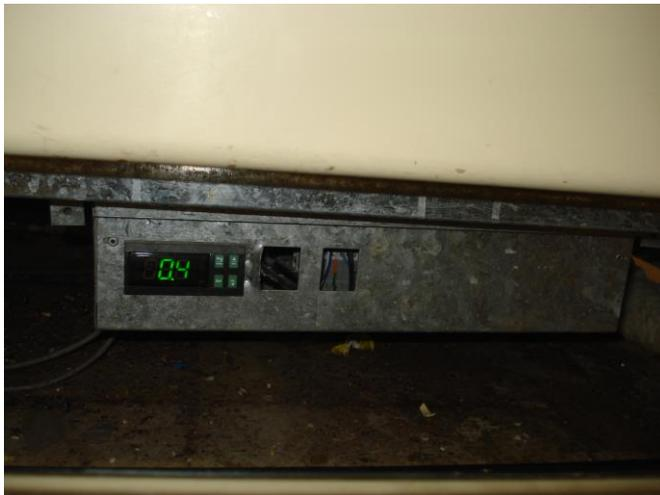
Fig.20 Tablero eléctrico con el controlador instalado en góndola de carnes.
