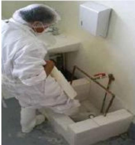
Figura N° 4: Ejemplos de lavabotas, lavazuelas y filtro sanitario.
