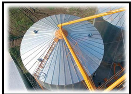
para diferentes necesidades de almacenamiento. Se construyen con chapas galvanizadas, acanaladas, fijadas a montantes con bulones y juntas hermetizadas.
