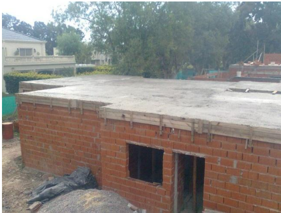
Figura 3.7: Techo terminado (con llenado).
