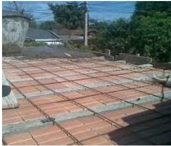
Figura 3.5: Armado de techo losa con viguetas.
