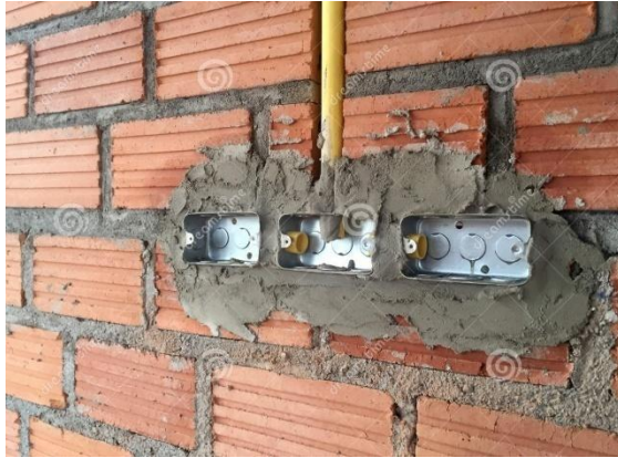
Figura 3.10: Instalación de cajas de electricidad.
