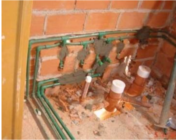
Figura 3.8: Instalación de agua.
