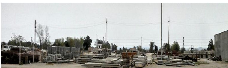
Figura 1.13: Área de almacenamiento exterior
