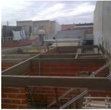
Figura 3.6: Encadenado previo al techo.
