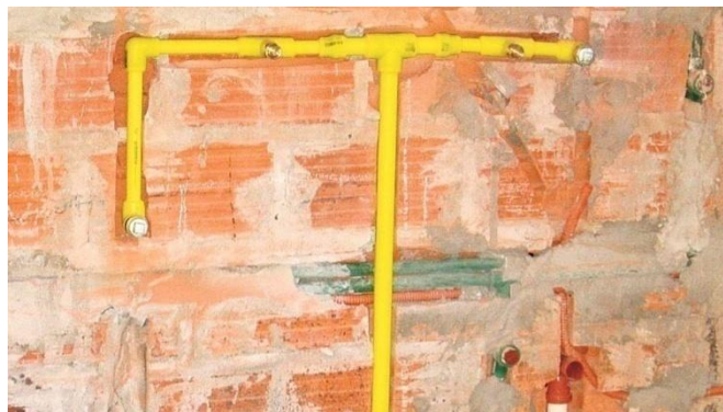
Figura 3.9: Instalación de gas termofusión.
