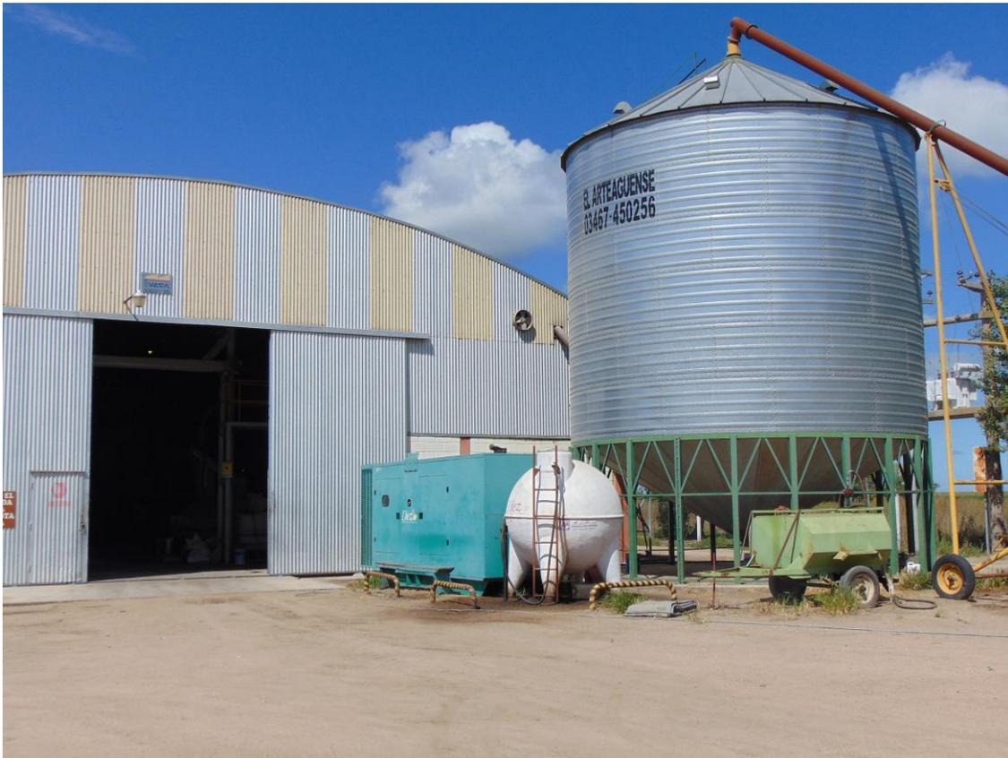
Entrada a la fábrica Diez SRL. Generador de apoyo eléctrico, tanque de combustible para funcionamiento de generador (para situación de corte de energía eléctrica), silo almacén de soja en grano (materia prima), y chimango transportador de granos.
