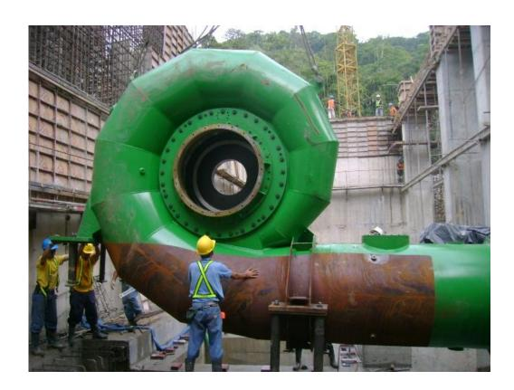
El diseño está preparado para soportar velocidades críticas, que le brinda a la máquina mejor estabilidad ante vibraciones y permitiendo reducir el costo de fabricación.
