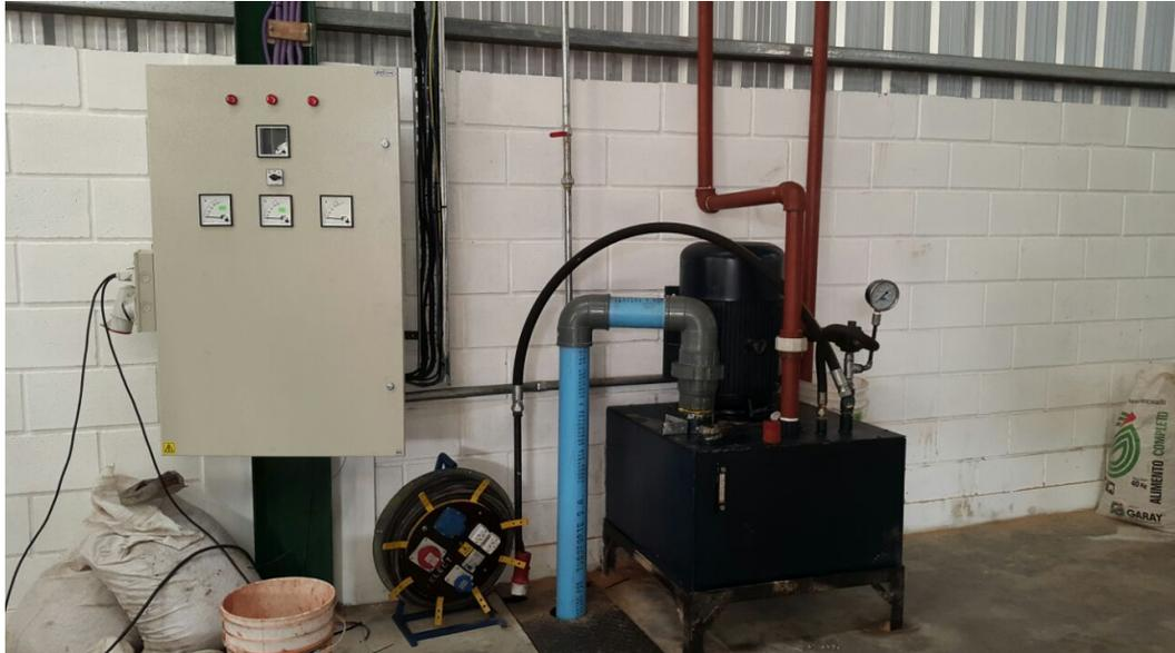
Tablero de comando y bomba hidráulica
